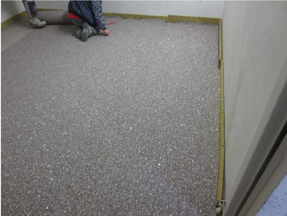
Abbildung A 2.1: Montagesituation PU-Schaumstoffmatte zur Trittschalldämmung
