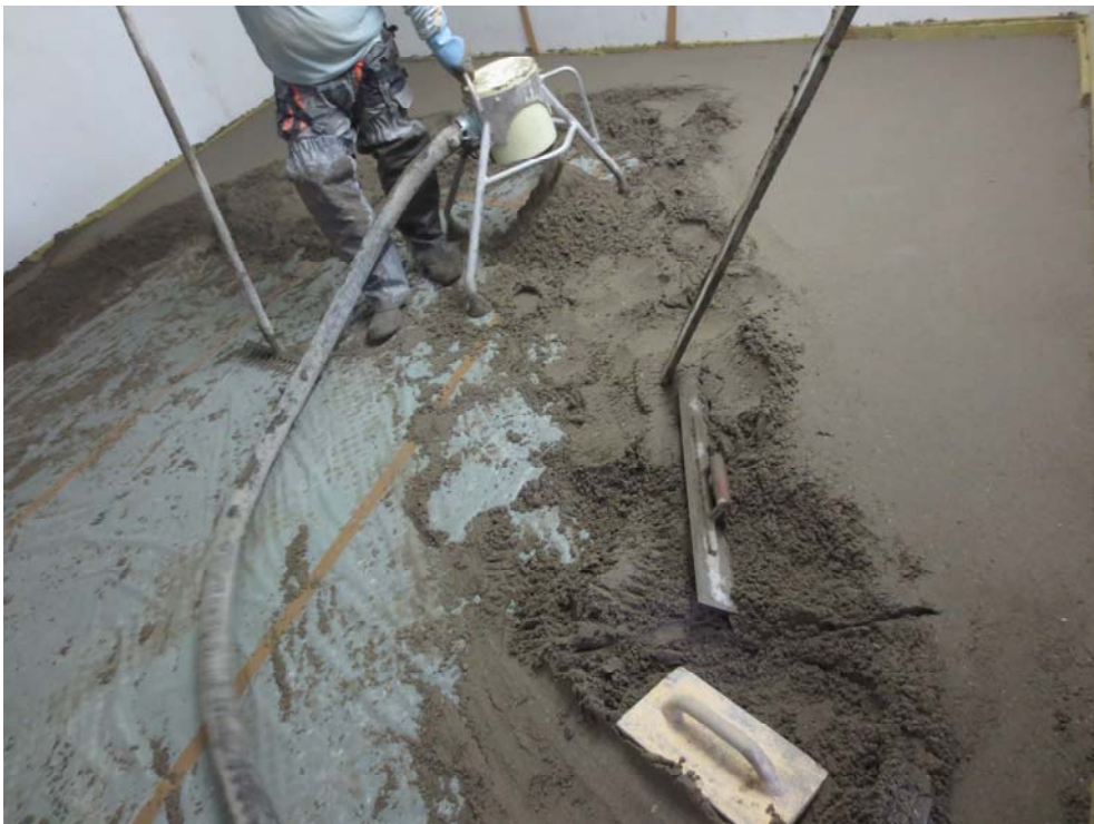
Abbildung A 2.2: Montagesituation mit Zementestrich und Folie
