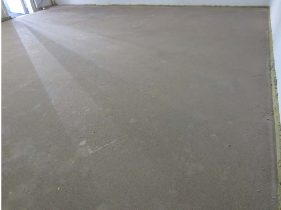
Abbildung A 2.3: fertig gestellter Zementestrich (Prüfsituation)
