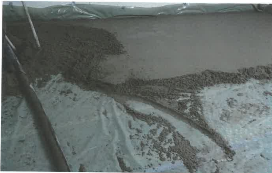
Abbildung A 2.2: Montagesituation mit Zementestrich
