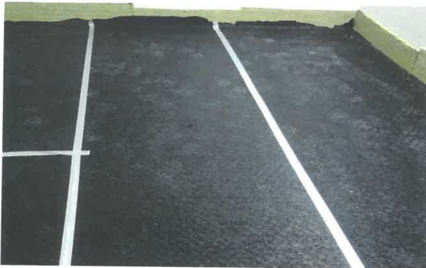
Abbildung A 2.1: Montagesituation mit Trittschalldämmmatten
